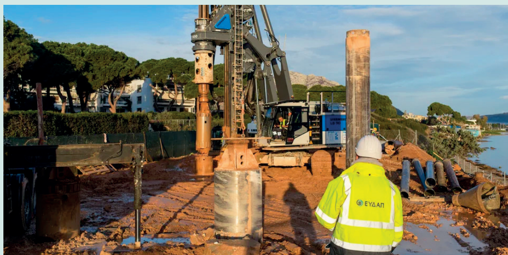
Εργασίες Κατασκευής Αντλιοστασίου Δήμου Μαραθώνος
